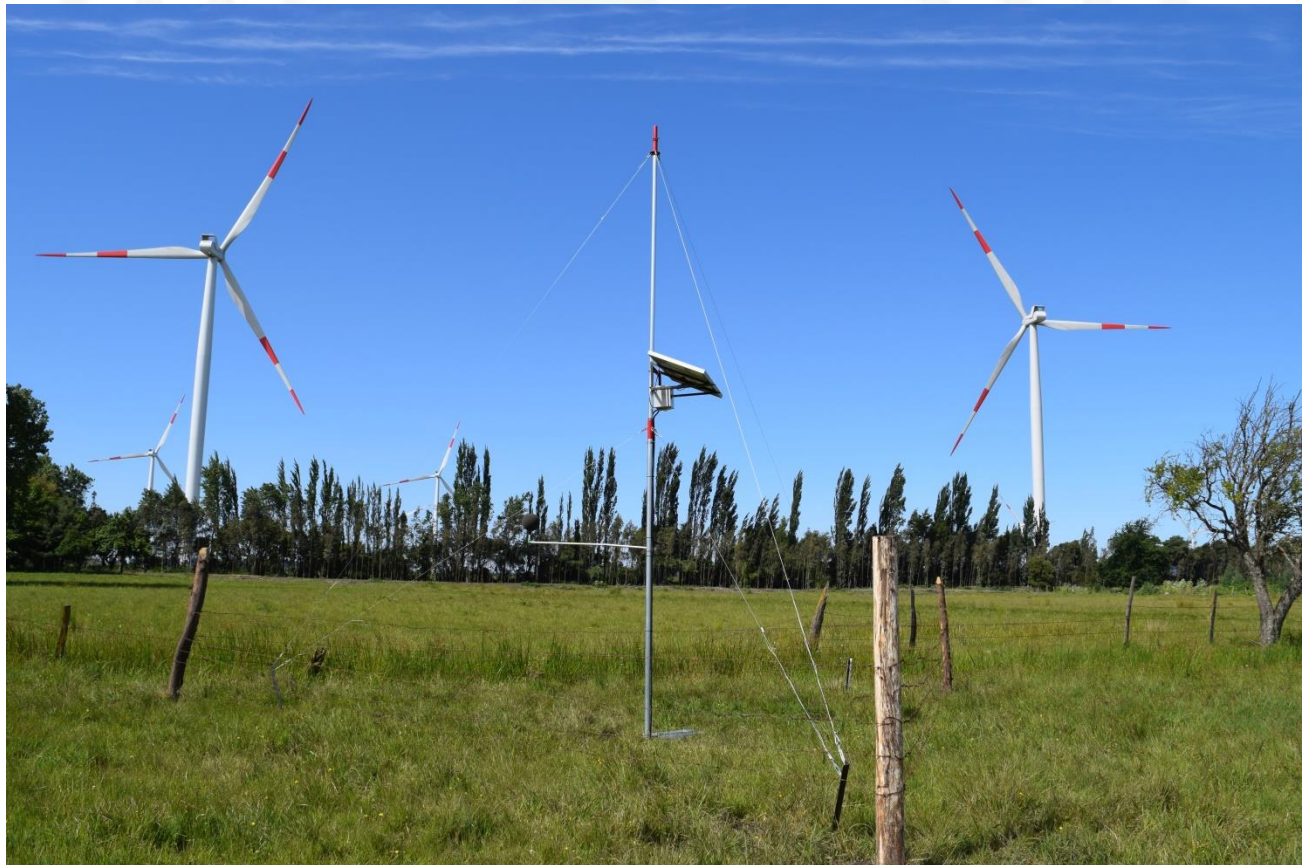
Figura 38. Estación de monitoreo de ruido en parque eólico 4 con cerco perimetral.
