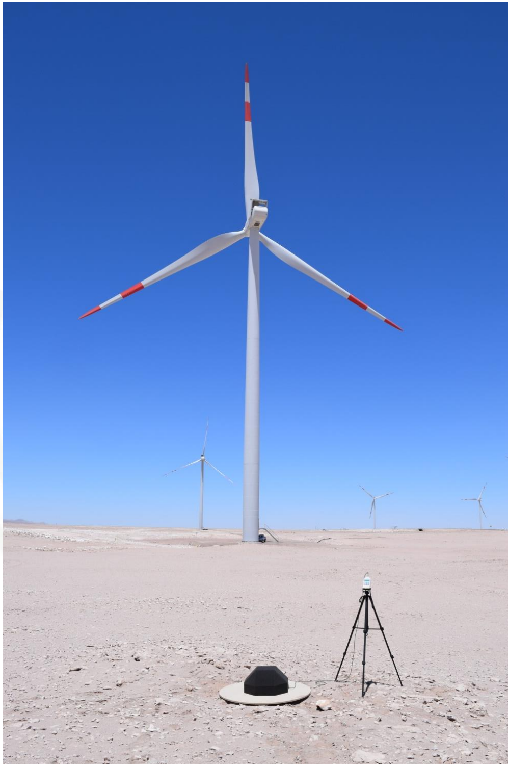
Figura 15. Medición de ruido de aerogenerador utilizando sonómetro Cesva SC310.
