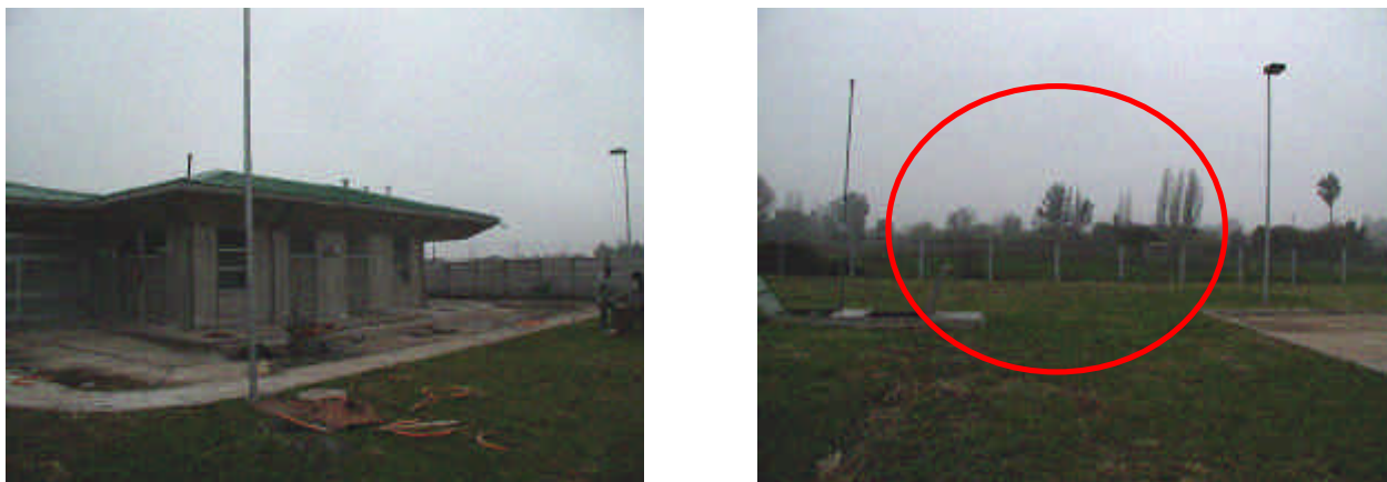
Figura 23. Vista interior del Consultorio de Santa Cruz. En círculo rojo sitio donde fueron emplazado el equipo HI MP 10 y Tubos pasivos ozono.
