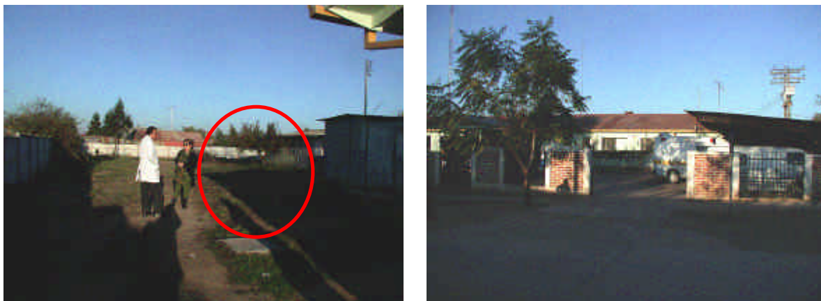
Figura 11. Vista interior del Hospital Marchigüe (foto izquierda) y vista desde la calle frontis de Hospital.
