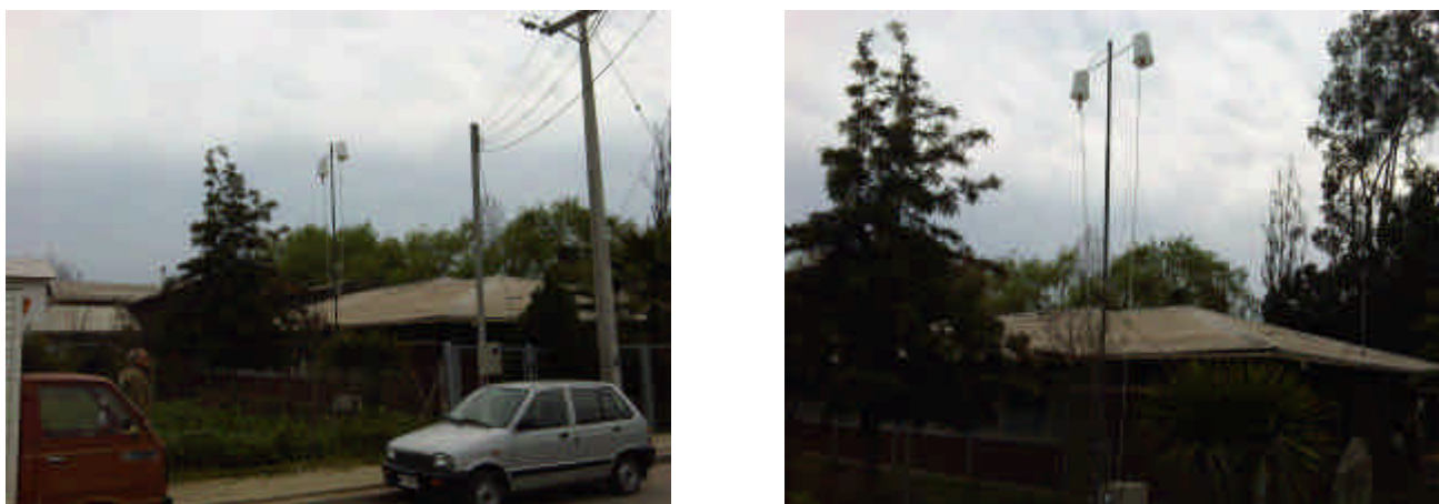
Figura 15. Vista exterior del Colegio Mistral e Instalaciones de equipos.
