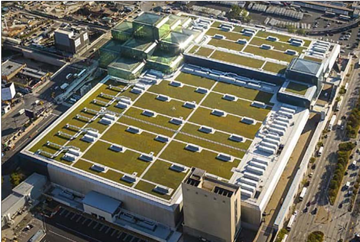
Figura 11 – Ejemplo de implementación de techo verde, Centro de Convenciones Javits, Nueva York, EE. UU.
