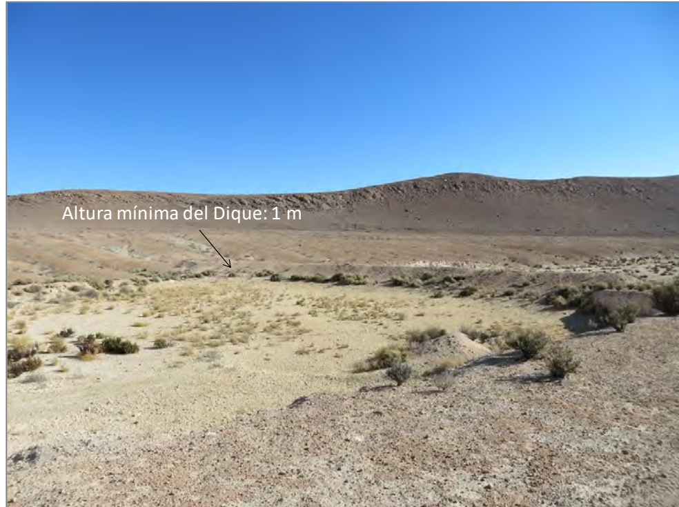
Figura 27. Dique Oeste, construido con material granular proveniente del suelo natural del sector. Fuente: Elaboración propia.
