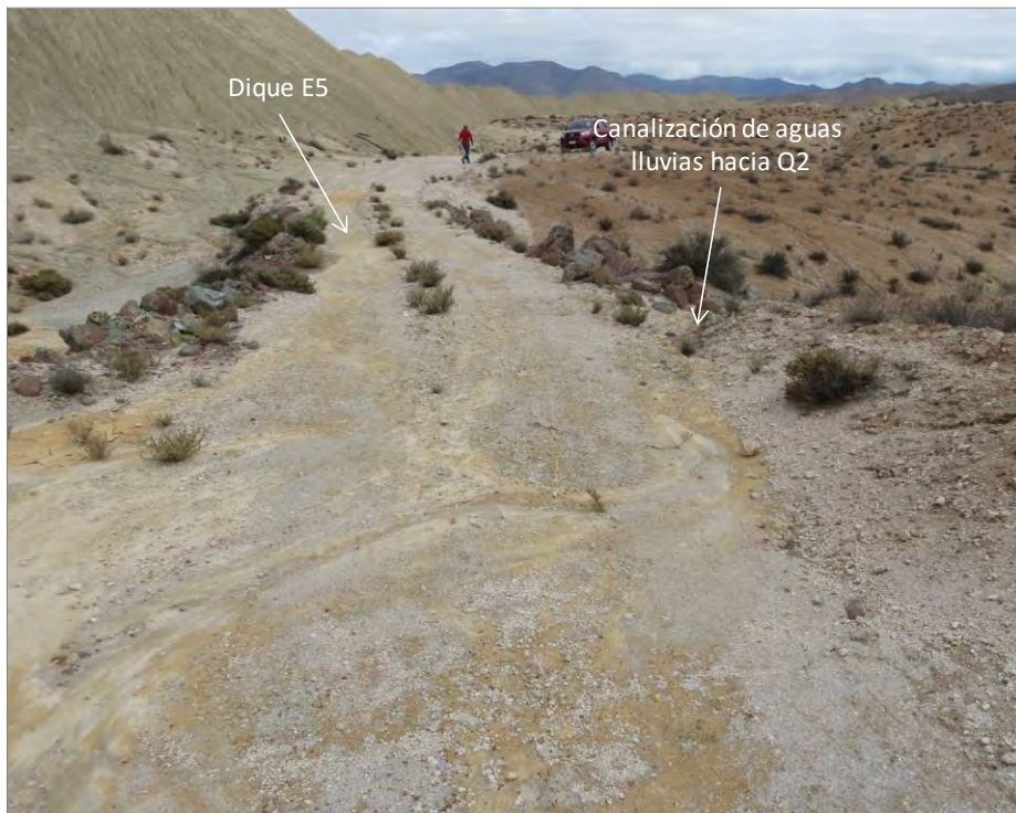
Figura 13. Detalle de dique E5 y canalización por agua lluvia hacia quebrada Q2. Fuente: Elaboración propia.
