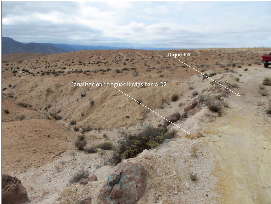
Figura 11. Vista de dique E4. Canalización por agua lluvia en su sección. Fuente: Elaboración propia.
