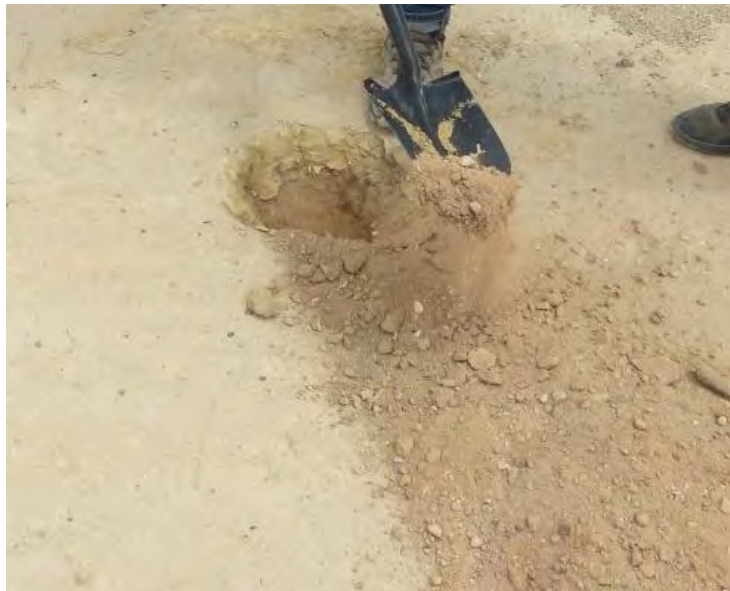
Figura 19. Detalle de residuos mineros esparcidos en Q4, muy finos y formando una capa de alrededor de 10 cm de espesor. Fuente: Elaboración propia.
