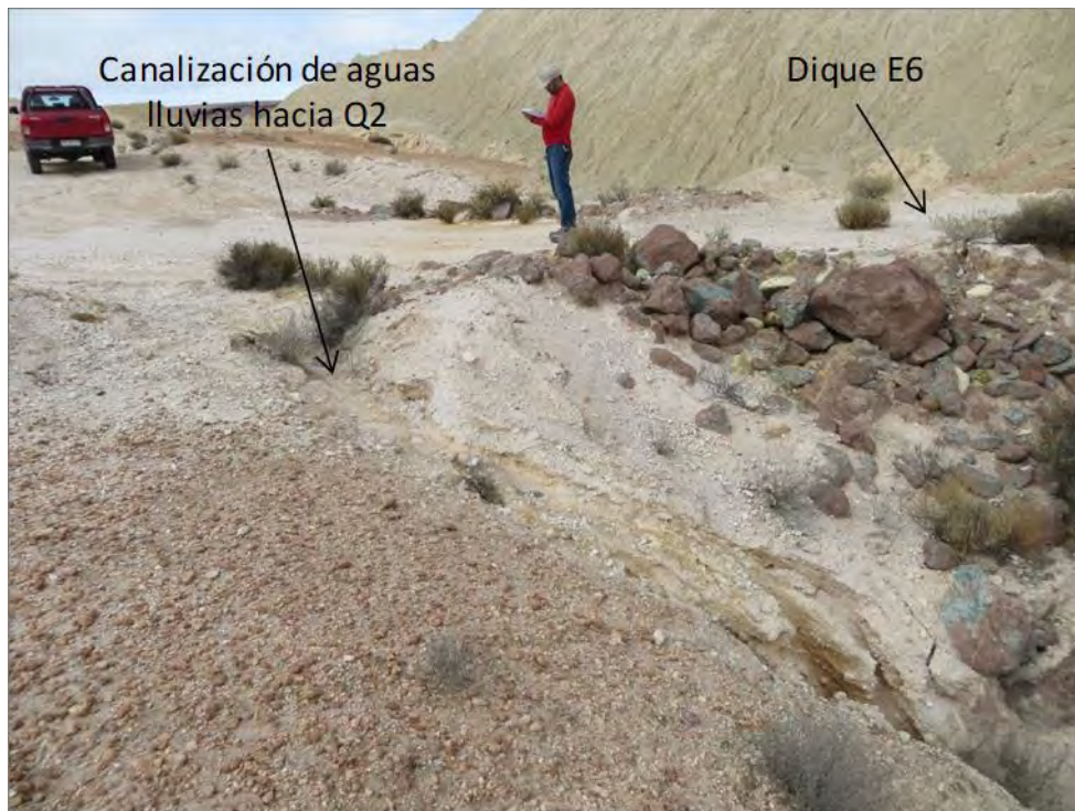
Figura 15. Vista de canalización por agua lluvia en superficie de dique E6 en Q2. Fuente: Elaboración propia.
