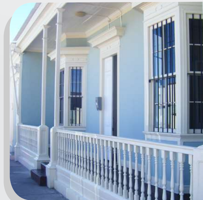
Oficinas del Centro de Estudios de Humedales en Pica
