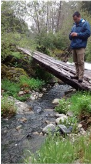
Ducto 2 Termas Los Pozones
