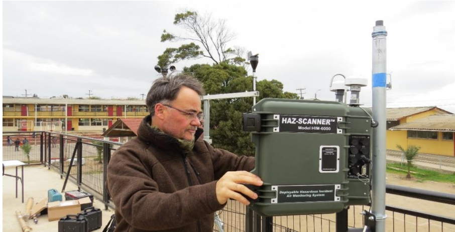
Figura 2.4 Instalación de equipo de monitoreo atmosférico
