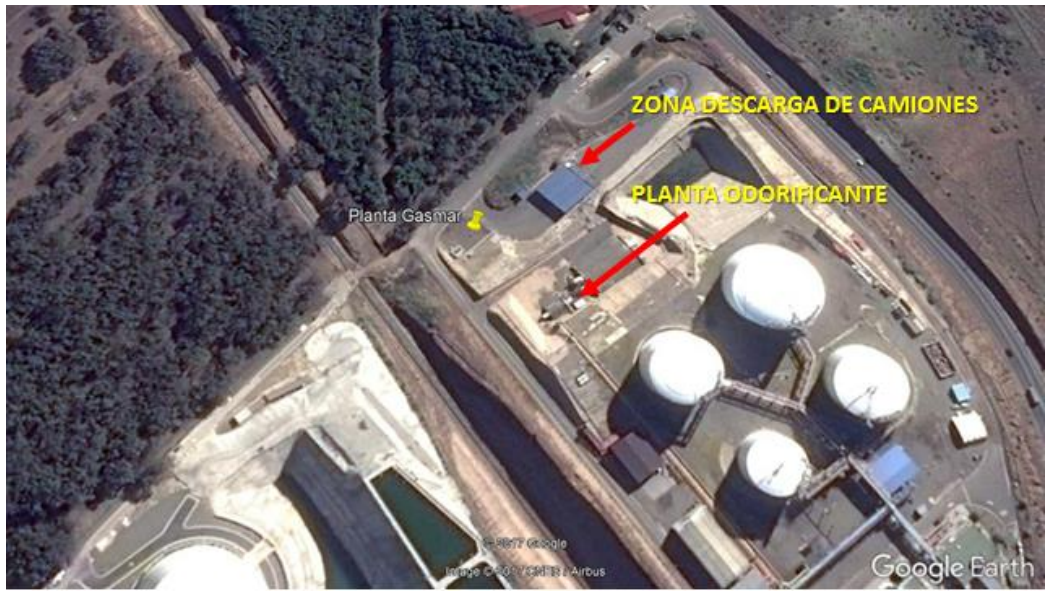
Figura 2.10 Ubicación del equipo dentro de Gasmar
