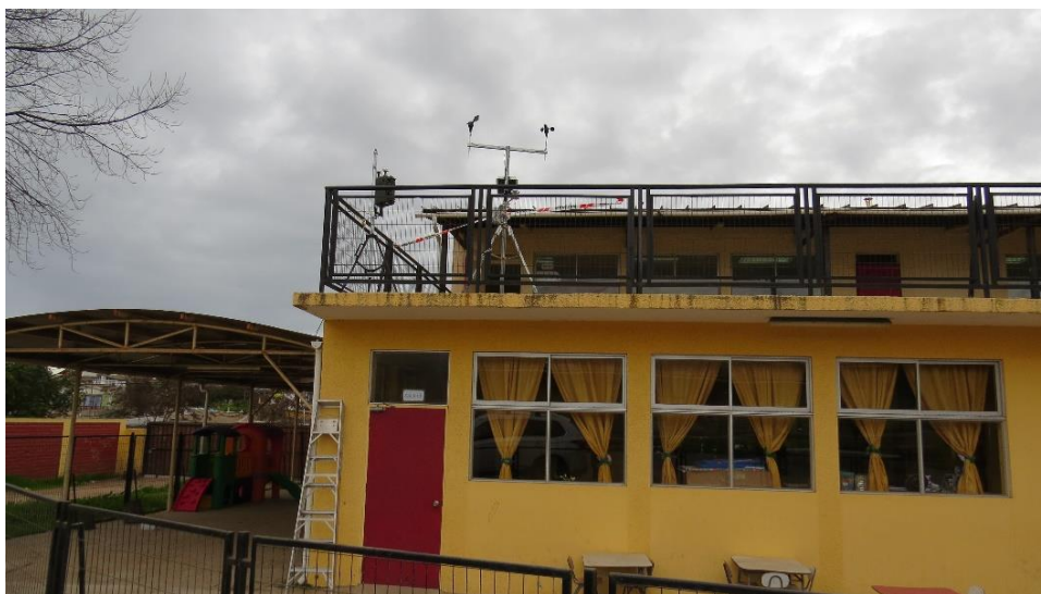
Figura 2.6 Terraza seleccionada para la instalación de los equipos
