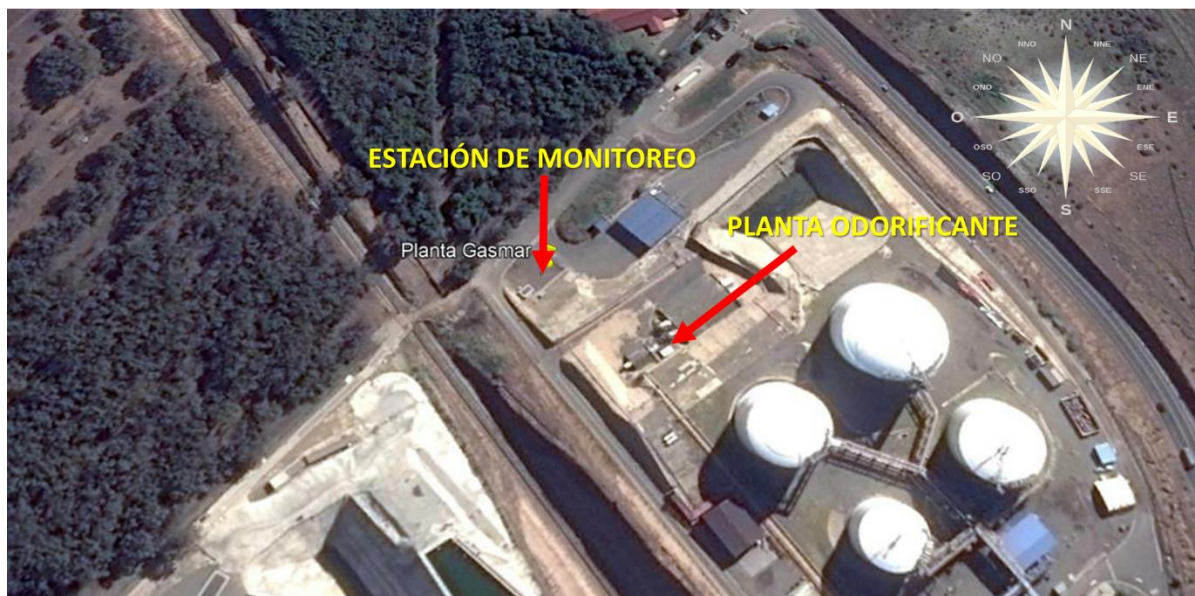
Figura 3.34. Ubicación de estación de monitoreo y planta de odorificación en Gasmar.
