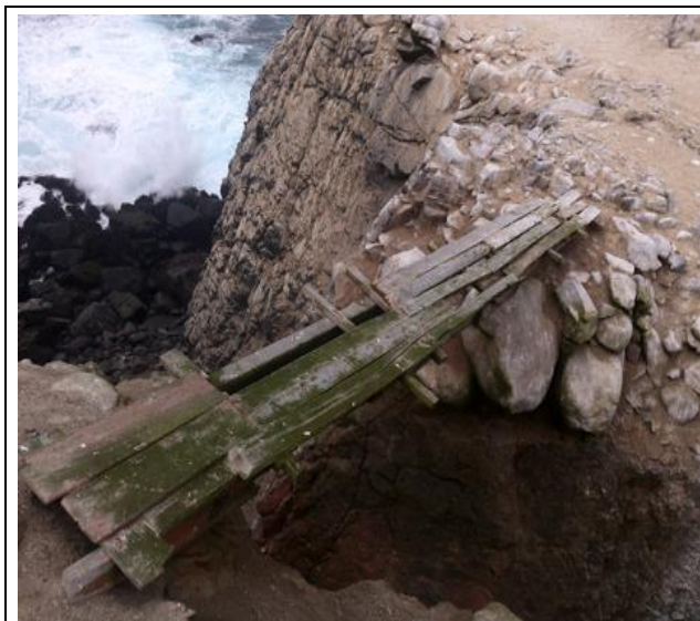
Fotografía PMPC - 36: Puente de madera en Isla Grande de Atacama posiblemente para extracción de guano.
