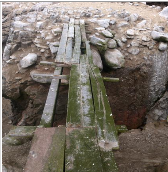
Fotografía PMPC - 37: Puente de madera, clavos y otros metales para unir dos sectores en Isla Grande de Atacama.
