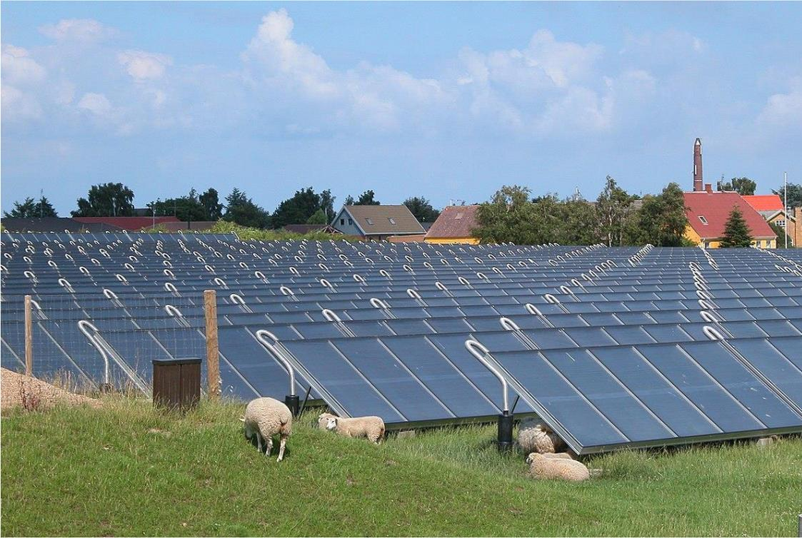
Ilustración 65. Ejemplo de sistema solar térmico para un sistema distrital en Europa
