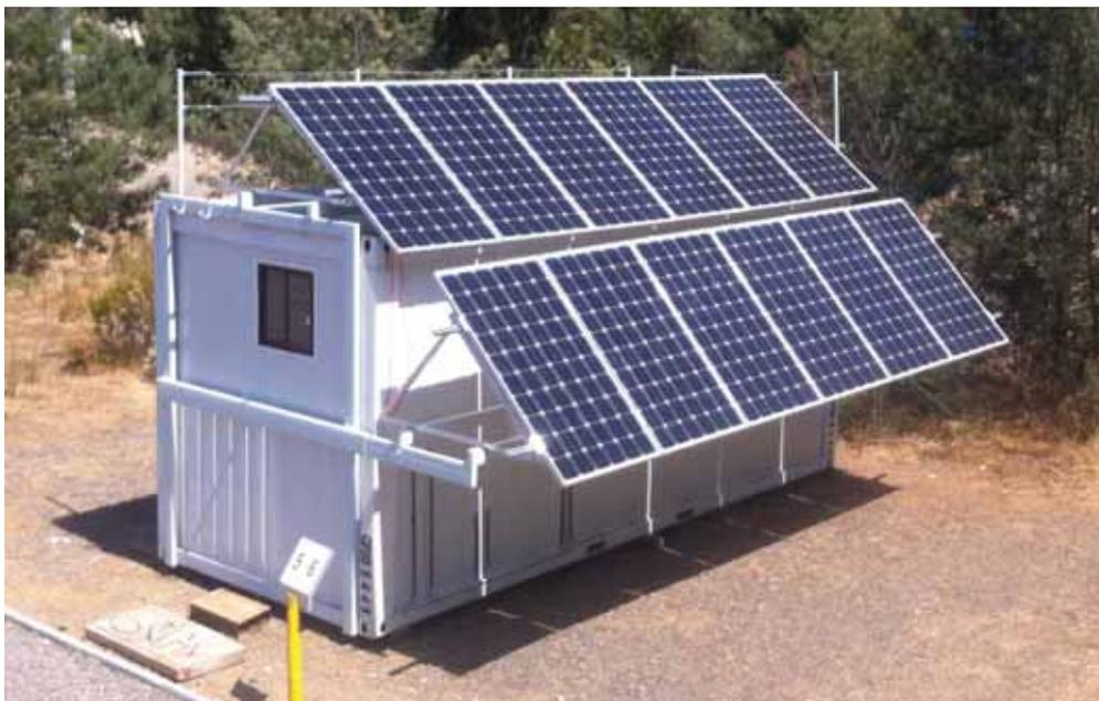
Laboratorio-refugio NUNATAK con sistema fotovoltaico de energía instalado
